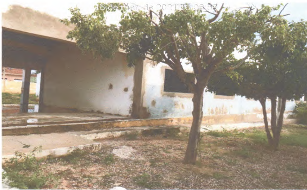
Fotos 02: Vista Interna da Entrada Principal
