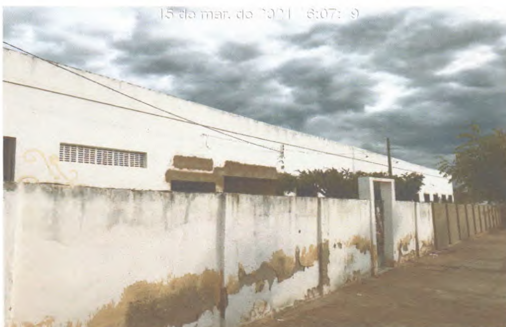
Fotos 03: Vista Externa da Entrada Principal
