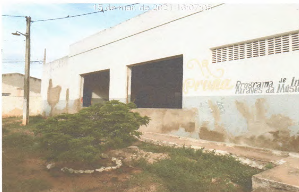
Fotos 04: Vista Externa da Entrada Principal
